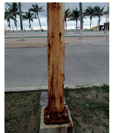
Riesgo. Debido al mal tiempo de los últimos días, estos se mueven peligrosamente.
