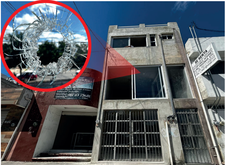
Susto. Así quedó la ventana con el impacto de bala.
